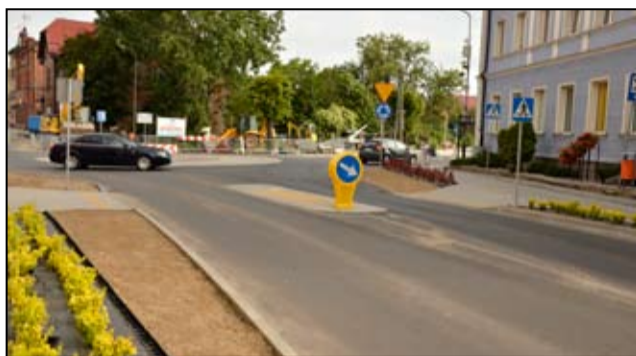
Prace przy budowie ronda dobiegły końca i przebudowane skrzyżowanie udostępniono kierowcom.
