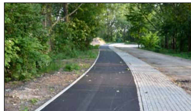
Ścieżki rowerowe w niektórych częściach miasta też wylane zostały nawierzchnią asfaltową. Czekamy teraz na kolejne etapy tej inwestycji.
