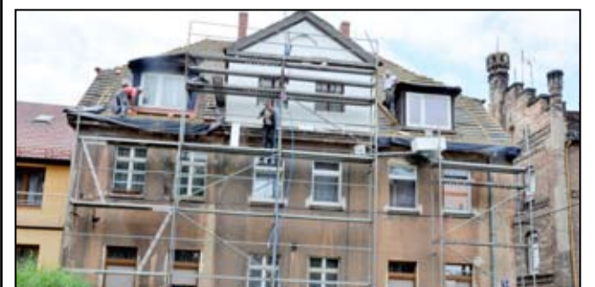
Budynek przy ul. Zamkowej 5 w Żarowie to pierwsza kamienica, która remontowana jest w ramach rewitalizacji miasta.
