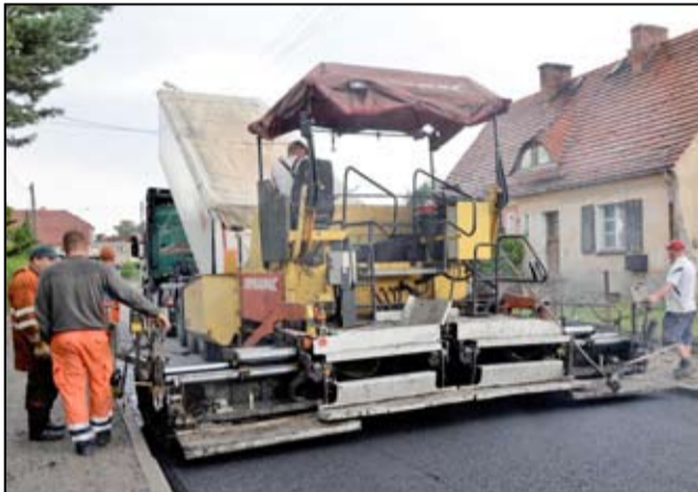
Stara nawierzchnia drogowa była już bardzo zniszczona. Mieszkańcy wsi z niecierpliwością czekali na jej modernizację.
