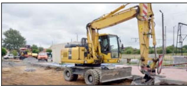
Pierwszy etap tej inwestycji już się zakończył i kierowcy mogą poruszać się bezpieczną nawierzchnią drogową.
