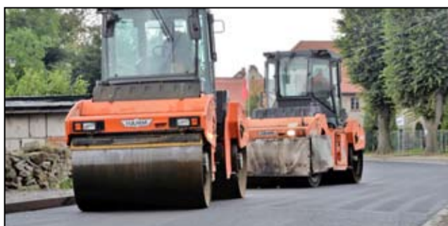
Odtworzenie nawierzchni drogowej kończy pierwszy etap zadania związanego z budową kanalizacji w Mrowinach.
