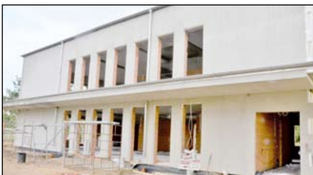
Gotowy jest budynek żłobka przy Bajkowym Przedszkolu w Żarowie. Teraz czas na realizację kolejnych prac.
