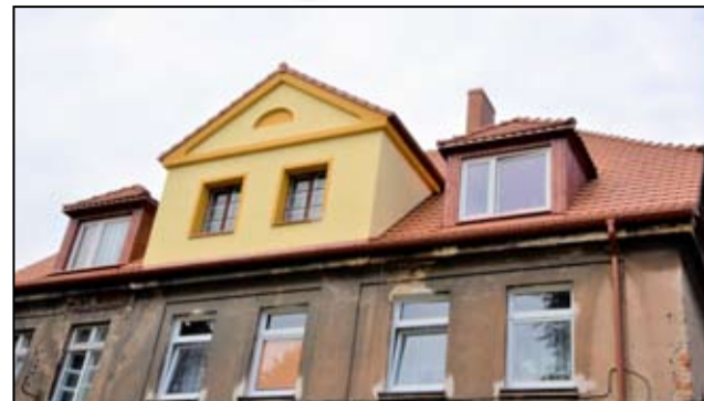
Budynek przy ul. Zamkowej 5 w Żarowie zyskał nowy dach i jest już po odbiorze technicznym.
