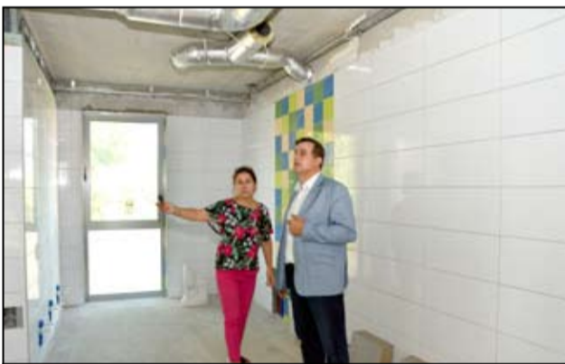
Plac budowy często odwiedzają burmistrz Leszek Michalak i dyrektor przedszkola Elżbieta Wierzyk.
