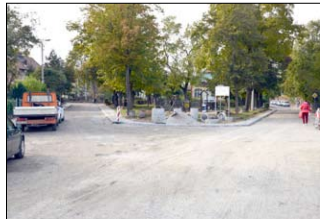
Plac Wolności w Żarowie niebawem zyska nową nawierzchnię asfaltową.
