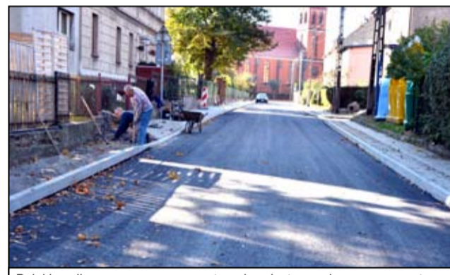
Dzięki realizowanym pracom na terenie miasta przybywa wyremontowanych dróg. Tu na zdjęciu wyremontowana ulica Słowackiego.
