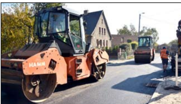
Plac Wolności i ulica Słowackiego zyskały już nową nawierzchnię asfaltową, dzięki czemu jest estetyczniej, ale przede wszystkim bezpieczniej.
