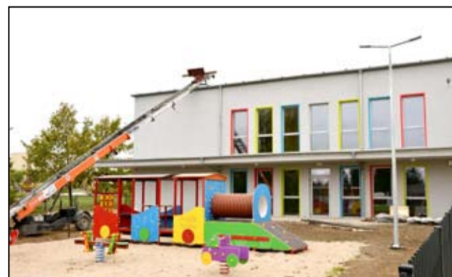
Przed budynkiem żłobka zamontowany został również nowy plac zabaw.
