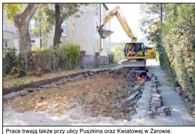
Prace trwają także przy ulicy Puskina oraz Kwiatowej w Żarowie.
