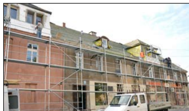
Niebawem budynek przy ul. Żarowskiej 34 w Imbramowicach będzie miał wyremontowany dach.
