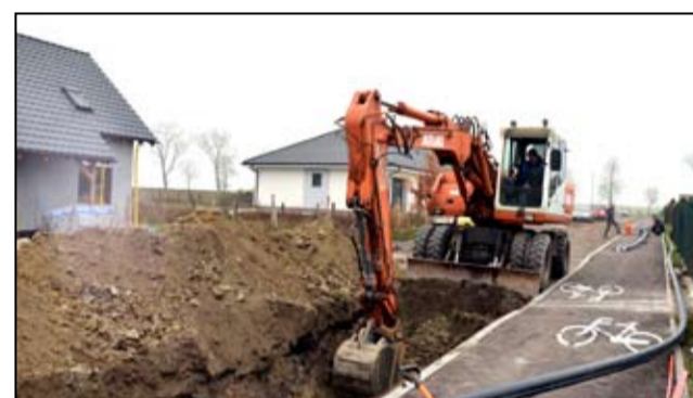
Budowa kanalizacji to kolejne ważne zadanie inwestycyjne na terenie Żarowa.
