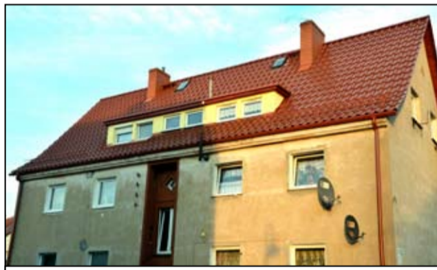
Wiele zadań zapisanych w projekcie rewitalizacji miasta Żarów dotyczy remontu dachów. Tu na zdjęciu budynek przy ul. Piastowskiej 2, gdzie kilka dni temu wymieniono zostało całe pokrycie dachowe.
