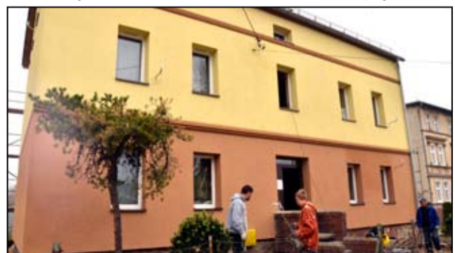
Budynek przy ul. Mickiewicza 21 w Żarowie zmienił swój wizerunek. Za kilka dni odbędzie się techniczny odbiór zrealizowanych tutaj prac.
