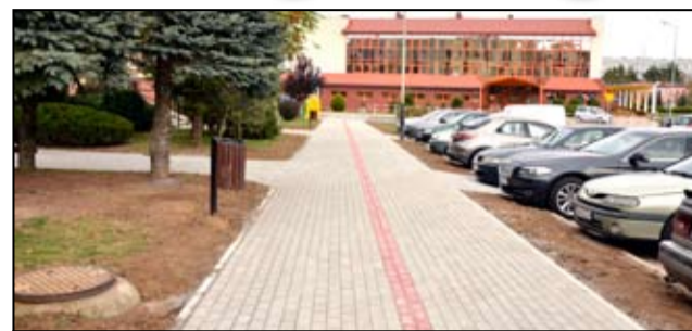
Tak wygląda wyremontowany chodnik przy ul. Krzywoustego w Żarowie. Gmina tę inwestycję zrealizowała wspólnie ze Spółdzielnią Mieszkaniową w Świebodzicach.
