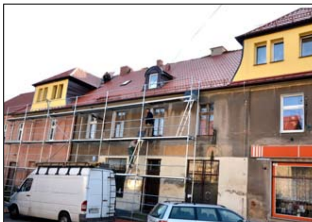
Dzięki realizowanym pracom budynek w Imbramowicach, gdzie mieści się także świetlica wiejska zyska wyremontowany dach.
