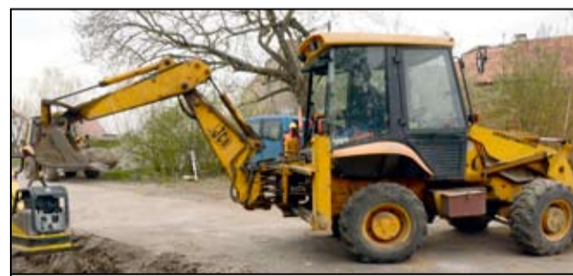
Prace przy budowie kanalizacji w Kalnie rozpoczęły się w grudniu 2018 roku.
