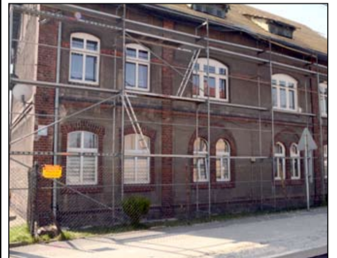
Prace w ramach projektu rewitalizacji miasta trwają także w budynku przy ul. Mickiewicza 10.
