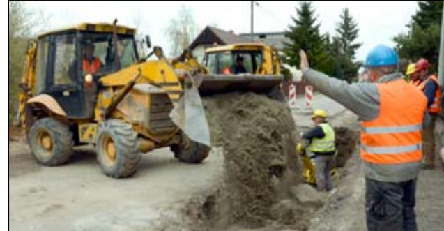
Cała inwestycja zakończy się odtworzeniem zniszczonej nawierzchni drogowej.
