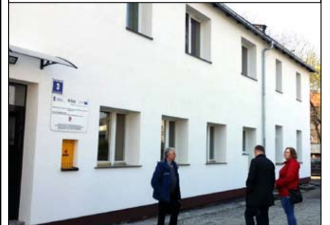
Budynek przy ul. Sportowej 3 w Żarowie po remoncie
