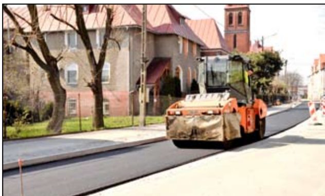
Kilka dni temu na zamkniętym odcinku dla ruchu ułożona została pierwsza warstwa nawierzchni asfaltowej.
