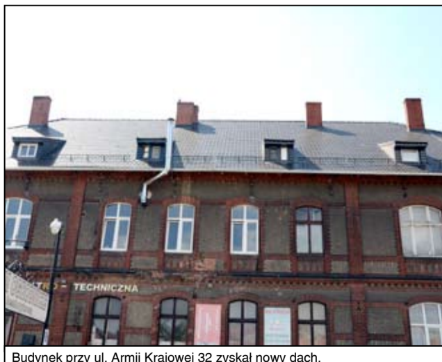
Budynek przy ul. Armii Krajowej 32 zyskał nowy dach.
