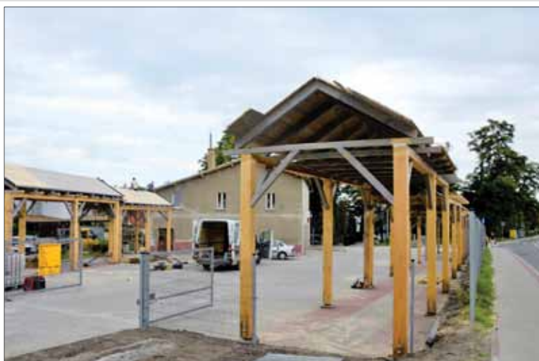
Trwa jeszcze montaż nowych wiat przy OSP Żarów. Będą tam prezentowane zbiory zabytkowego sprzętu bojowego.
