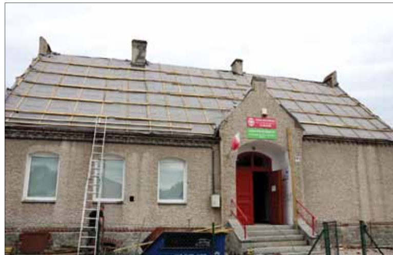
W SP Zastruże, w ramach wakacyjnych prac, wyremontowany został dach.
