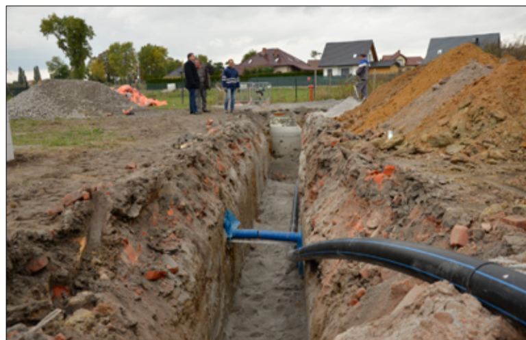
Rozpoczęły się kolejne prace przy budowie kanalizacji na osiedlu domków jednorodzinnych w Żarowie.
