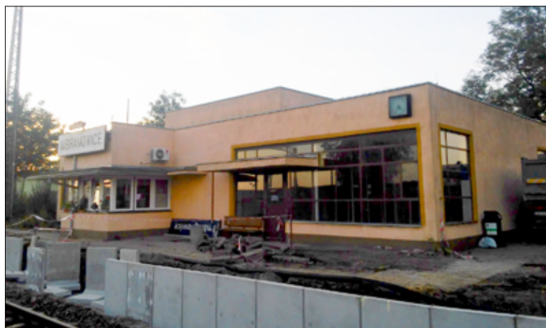
Budynek dworca przed remontem.
