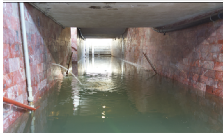
Zalane przejście podziemne w Żarowie. Taki stan obiektu utrzymuje się już od kilku miesięcy.
