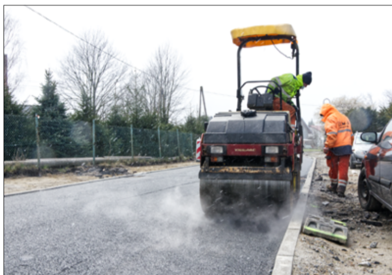
Ostatnim etapem prac jest remont chodnika i budowa ścieżki pieszo-rowerowej.
