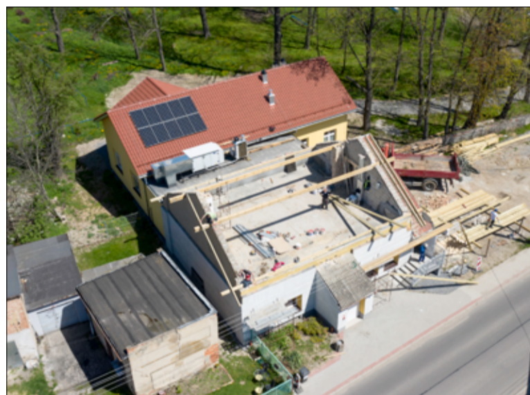
W tej chwili wykonywane są roboty polegające na remoncie dachu oraz przestronnej sali spotkań przeznaczonych dla lokalnej społeczności. więcej na stronie 4.
