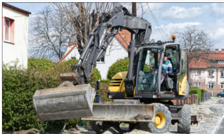
Prace przy remoncie nawierzchni chodnika potrwają jeszcze kilka tygodni.
