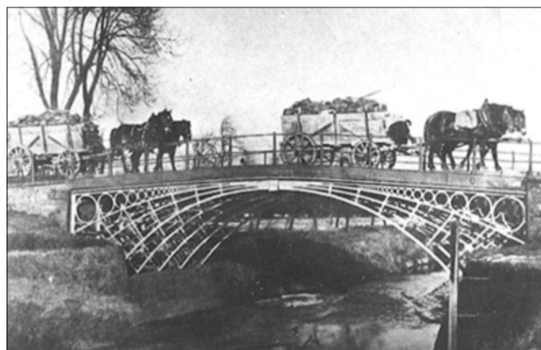
W tym roku mija 225 lat od powstania na Śląsku drogowego mostu na rzece Strzegomka.
