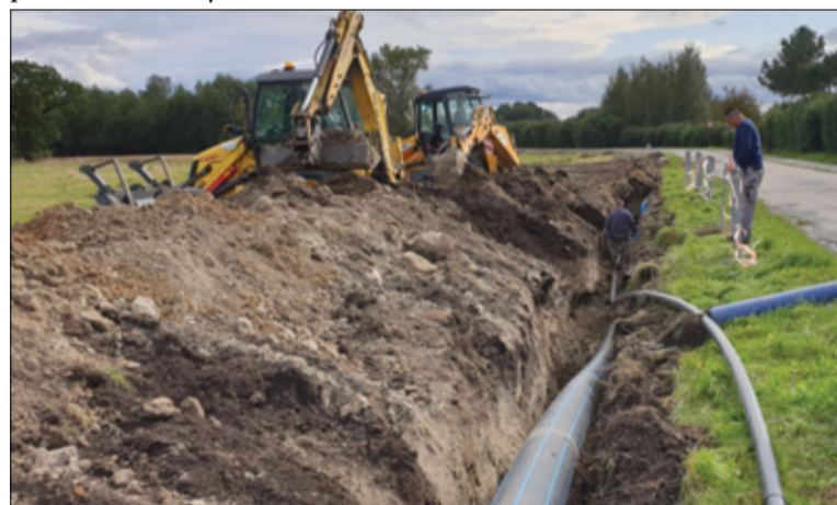
Budowa nowego wodociągu to była bardzo potrzebna inwestycja.
