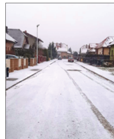
Drogi przy ul. Brzozowej, Kasztanowej i Klonowej to drogi, które wymagają modernizacji.
