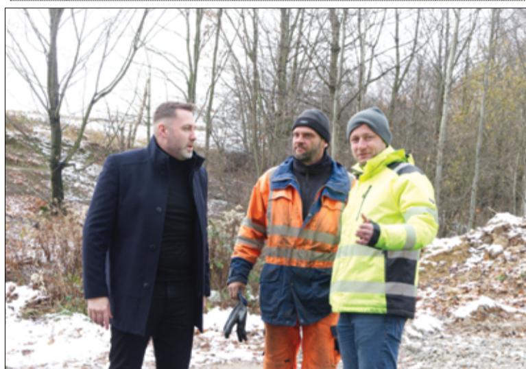
Prace przy budowie drogi w Wierzbnej nadzorowali pracownicy Urzędu Miejskiego w Żarowie, burmistrz Leszek Michalak i zastępca burmistrza Przemysław Sikora.
