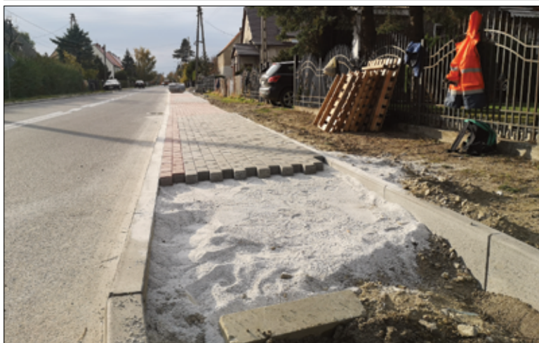
Trwa budowa chodnika w kolejnej części ul. Wojska Polskiego w Mrowinach.
