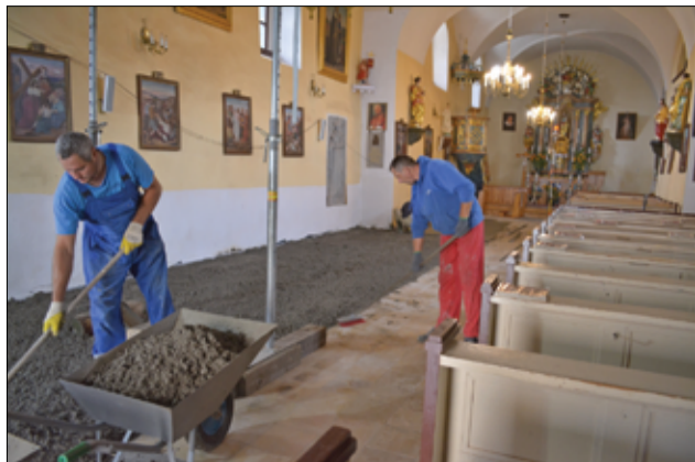
Prace przy renowacji zabytków w kościele realizowane były w dwóch etapach. (Foto: Maciej Kwarciak).
