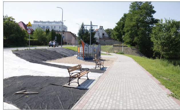
Zrealizowane prace już zmieniły teren przy stawie miejskim w Żarowie. Końcowy efekt zobaczymy, kiedy nasadzona zostanie liczna roślinność.
