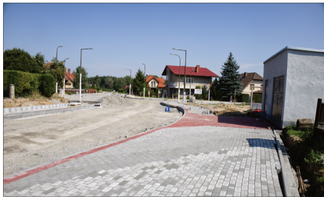
Remonty dróg są już na półmetku, a na zakończeniu prace związane z budową nowych chodników i montażem lamp oświetleniowych.
