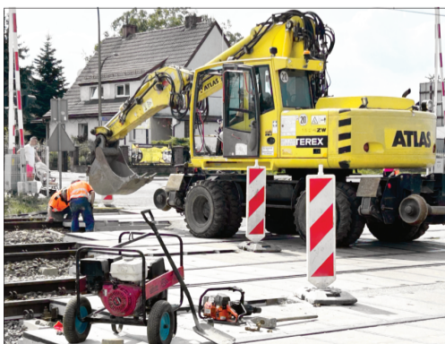
Prace polegają na poszerzeniu nawierzchni na przejeździe kolejowym.
