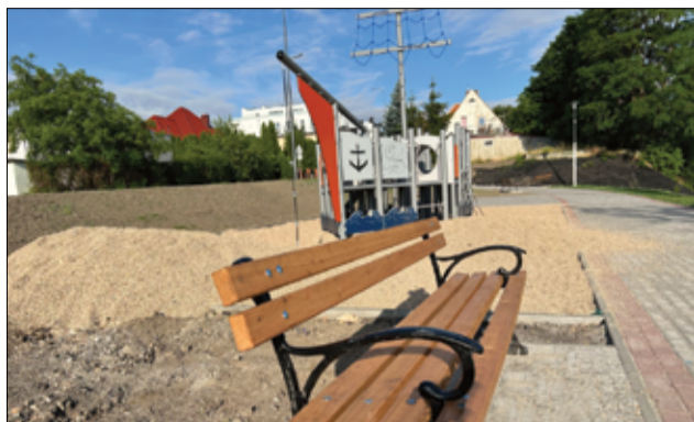
W tej chwili zagospodarujemy teren przy stawie i montowane są ławki, leżaki, kosze na śmieci i inne elementy.
