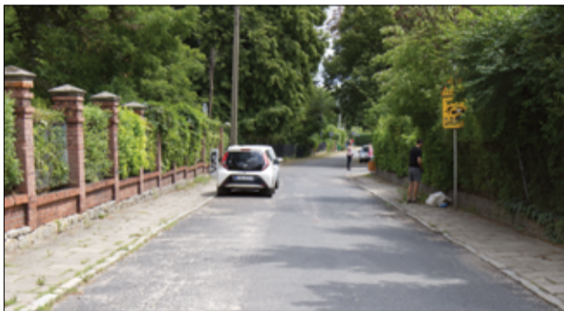
Droga przy ul. Hutniczej w Żarowie wymaga kompleksowej przebudowy.
