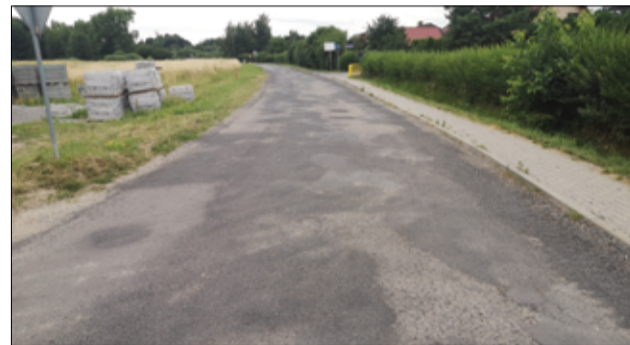
Przebudowany zostanie również odcinek drogi przy skrzyżowaniu ul. Wyspiańskiego (w kierunku Kalna).
