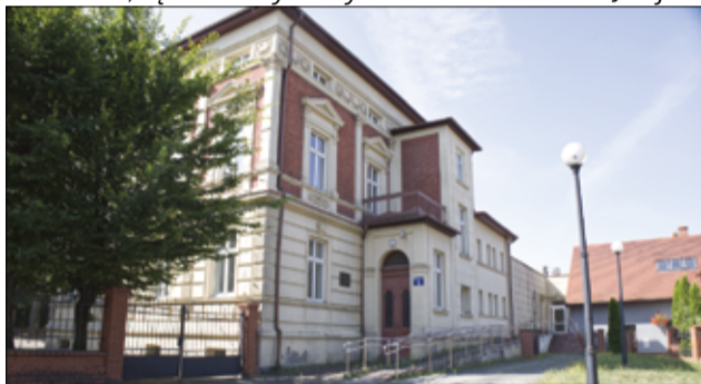
Zabytkowa Willa Treutler-Schlosser już niebawem doczeka się gruntownego remontu.
