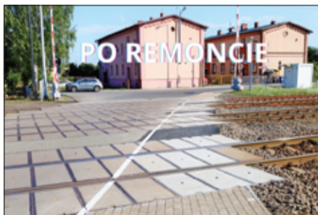
Wielokrotne interwencje przyniosły efekt i przy przejeździe kolejowym wykonane zostało bezpieczne przejście.
