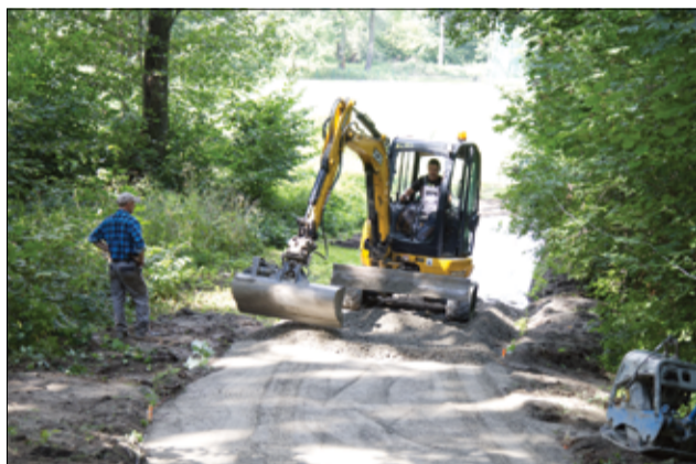
W tej chwili w parku prowadzone są prace przy przebudowie alejek.
