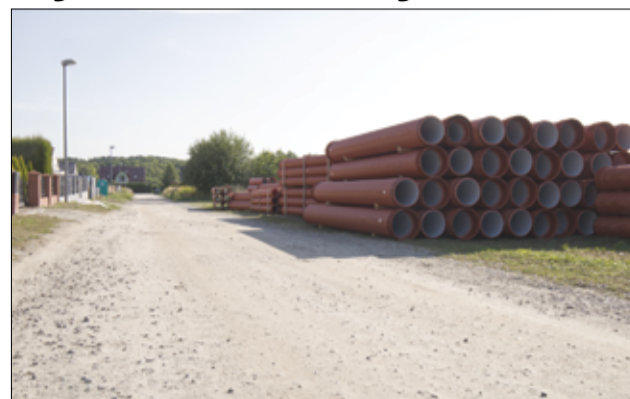
Niebawem rozpocznie się również remont dróg przy ul. Bukowej, Wierzbowej i Jodłowej w Żarowie
