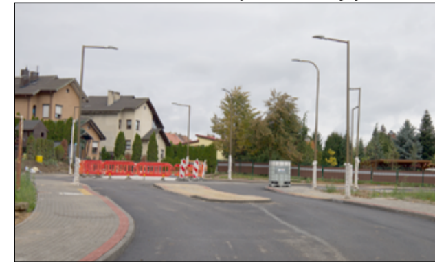
Bez dziur i żadnych niedogodności. Kolejne drogi na terenie domków jednorodzinnych mają nowe nawierzchnie asfaltowe.
