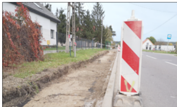
Rozpoczęliśmy już prace przy budowie kolejnych chodników na terenie naszych wsi.
