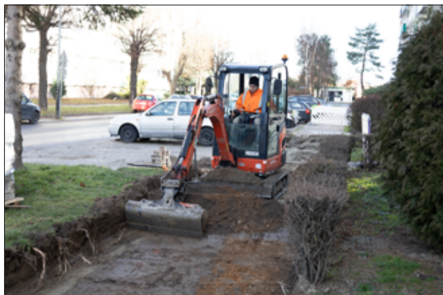
Zniszczony chodnik przy ul. Łokietka w Żarowie doczekał się przebudowy.
