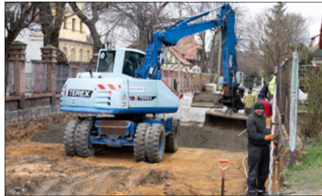
Rozpoczęliśmy także prace przy remoncie drogi na ul. Hutniczej w Żarowie. Jest to już kolejna droga w tej części naszego miasta, która doczeka się gruntownej modernizacji.
