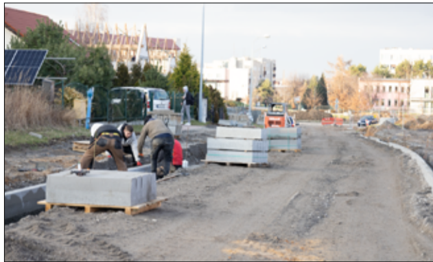
Mieszkańcy ul. Ks. Jadwigi muszą uzbroić się jeszcze w cierpliwość. Trwa tutaj przebudowa drogi, powstają również nowe chodniki.
